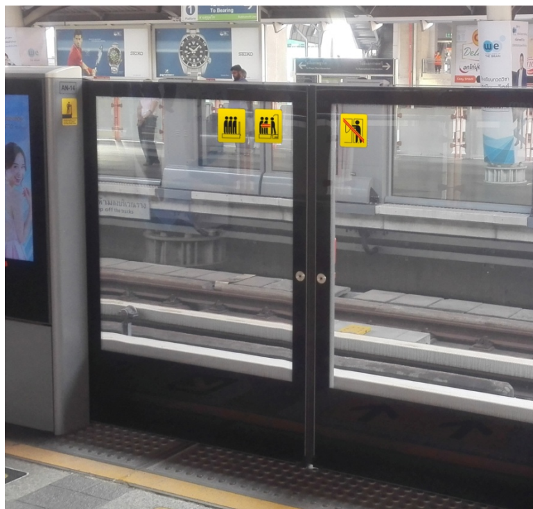
ภาพที่ 17 ตำแหน่งติดตั้งป้ายสัญลักษณ์บริเวณประตูอัตโนมัติระหว่างชานชาลา (ผู้วิจัย, 24 เม.ย. 2559)
