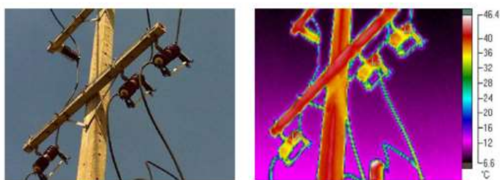
ภาพที่ 18 ตัวอย่างภาพถ่ายความร้อนบริเวณเสาไฟฟ้าแรงสูงหน้าโรงงาน
