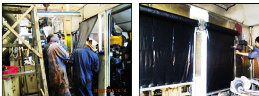
ภาพที่ 4-8 การติดตั้งชุดม่านป้องกันสะเก็ดเชื่อม
