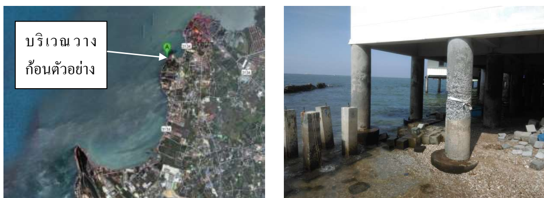
ภาพที่ 3-25 สถานที่ทดสอบคอนกรีตภายใต้สิ่งแวดล้อมทะเล
