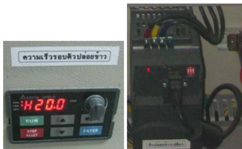
ภาพที่ 3-6 อุปกรณ์ควบคุมความเร็วข้าวเปลือกเข้าเครื่องอบ
