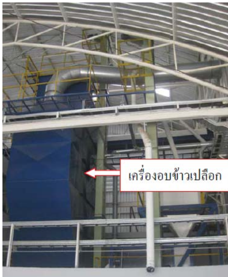
ภาพที่ 3-2 เครื่องอบข้าวของโรงงานกรณีศึกษาความจุ 500 ตันแบบคอลัมน์
