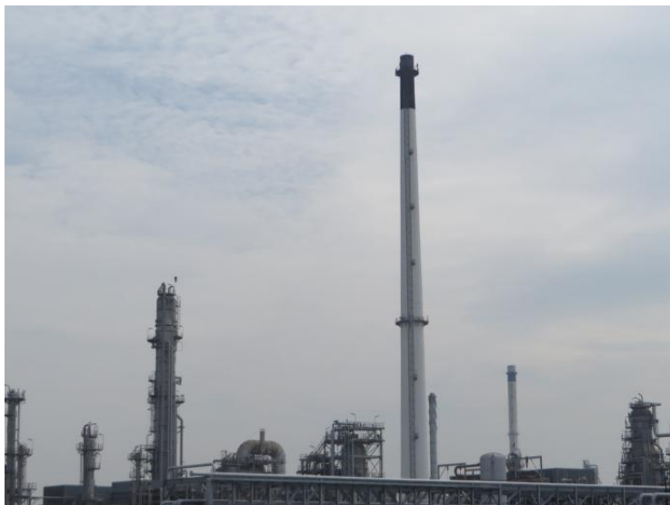
ภาพที่ 2-20 ตัวอย่างปล่องระบายไอเสีย (Stack) บริษัท ไทยออยล์ จำกัด (มหาชน)
