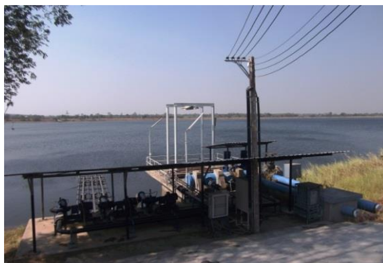
ภาพที่ 1-3 อ่างเก็บน้ำดิบ
