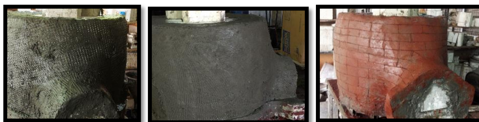
ภาพที่ 5-39 การวางลวดตาข่ายบนผนังของเตาเผา (กฤตยชญ์ คำมิ่ง, 2557)
