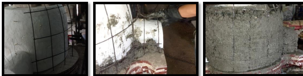
ภาพที่ 5-38 การพอกวัสดุคืบที่ผนังเตาและตัวเตาเผา (กฤตยชญ์ คำมิ่ง, 2557)
