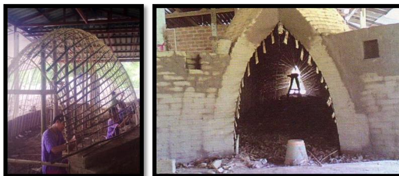
ภาพที่ 2-37 การก่อผนังเตาโดยใช้ไม้ไผ่เป็นโครง (สุรัตน์ บัวหิรัญ, 2549)
