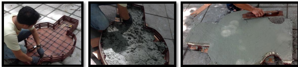
ภาพที่ 5-37 การเทวัสดุคืบลงบนฐานของเตาเครื่องปั้นดินเผาโมญู (กฤตยชญ์ คำมิ่ง, 2557)
