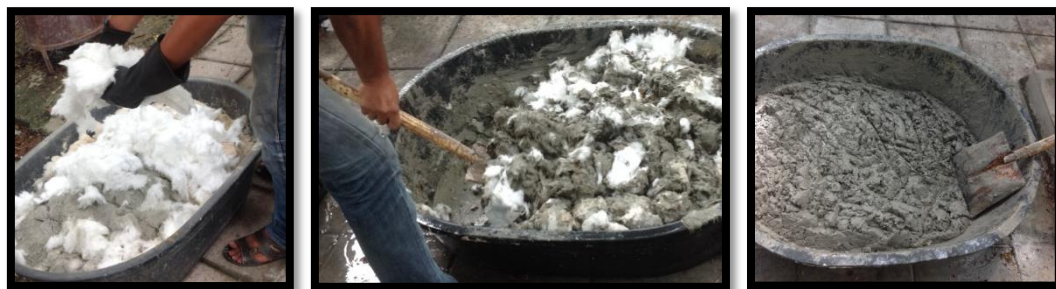
ภาพที่ 5-36 การผสมวัตถุดิบที่จะใช้ในการสร้างเตาเครื่องปั้นดินเผา (กฤตยชญ์ คำมิ่ง, 2557)
