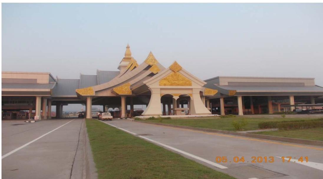
ภาคผนวก ก-1 รูปแบบสะพานมิตรภาพ 3 (นครพนม-คำม่วน) ภายหลังการก่อสร้าง พ.ศ. 2555
