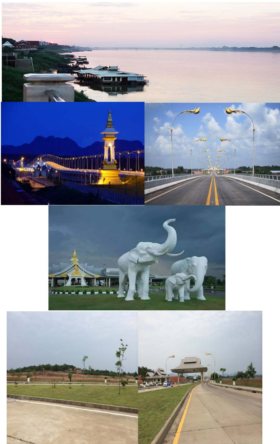
ภาคผนวก ก-21 สะพานมิตรภาพ3 (นครพนม-คำม่วน)
