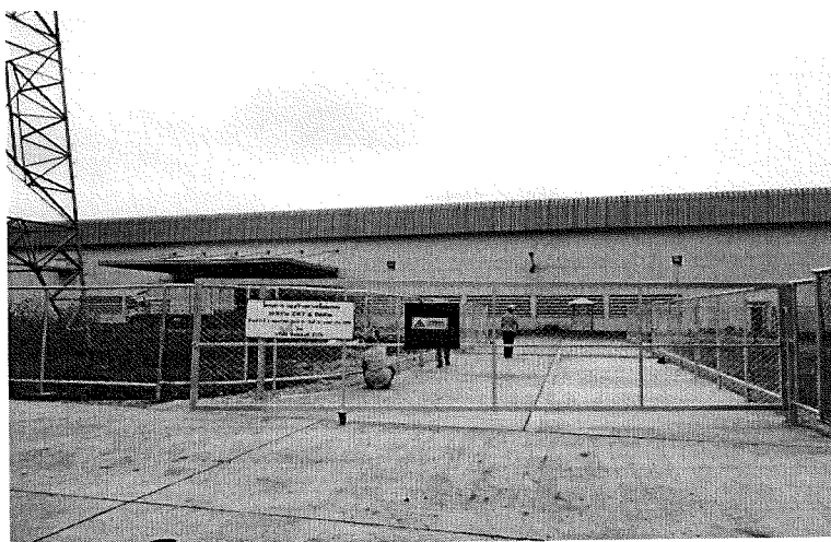
ภาพที่ 4-10 ถนนคอนกรีตที่สร้างเพื่อเชื่อมต่อระหว่างบริษัทกรณีศึกษาและบริษัทผู้จัดหาวัตถุดิบ ที่มา: ฝ่ายควบคุมโรงงาน บริษัทกรณีศึกษา
